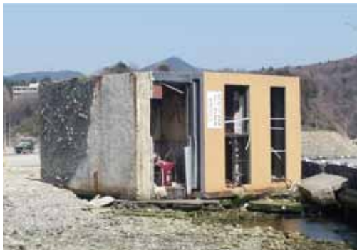
片付けずに残されたビル 左が基礎
