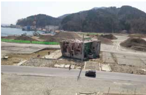
震災後の女川町 現在も片付けられずに残されたビル（基礎ごと倒された）
