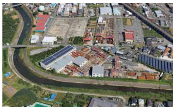
(株)青木鐵工所豊野工場上空写真
